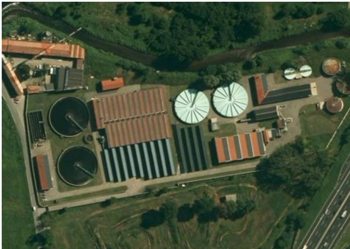
Il depuratore di Olgiate Olona
