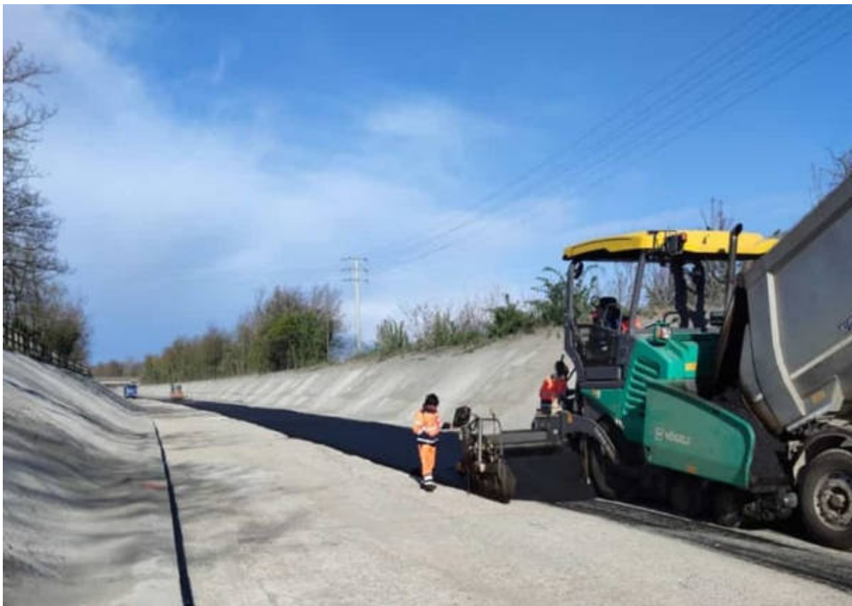
Gli interventi di impermeabilizzazione sul Villoresi
