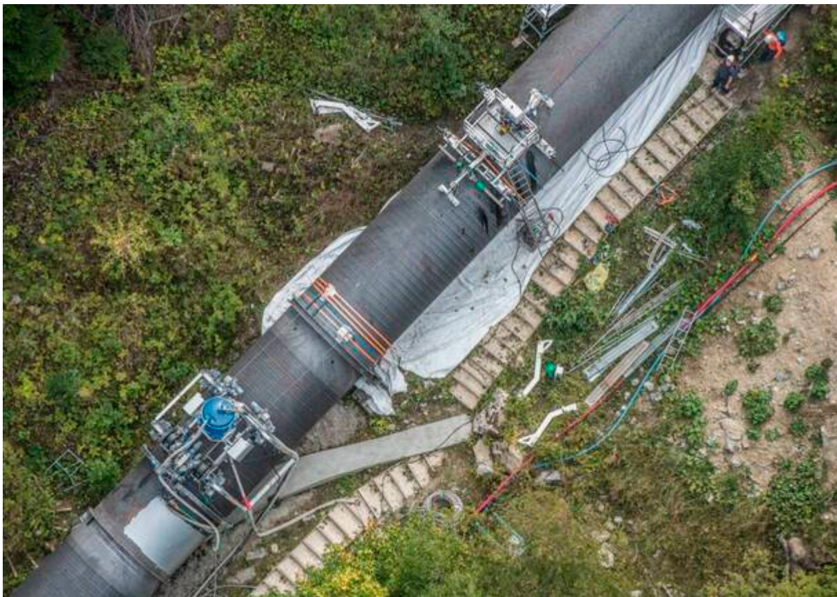
(Due robot all'opera per la rimozione di un rivestimento da una condotta forzata sulle alpi francesi)
