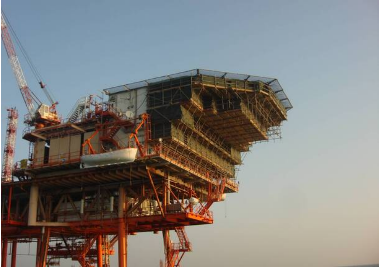
(Intervento di manutenzione di una piattaforma offshore nel mar Adriatico)
